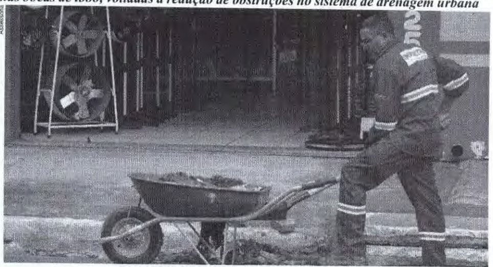
Os serviços de desobstrução de bocas de lobo começaram no fim de 2025 e continuam em execução nos bairros da cidade
