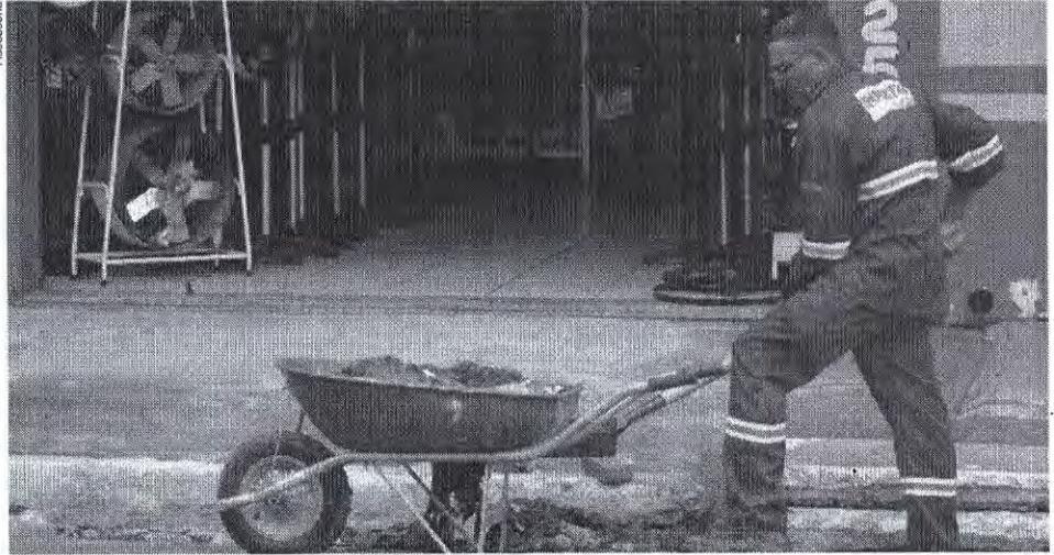
Os serviços de desobstrução de bocas de lobo começaram no fim de 2025 e continuam em execução nos bairros da cidade
