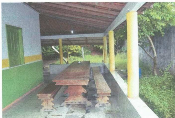
Foto 06 – Telhado em Telha Cerâmica e Madeira
