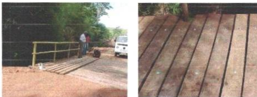
Figura 14 - Tabuleiros transversal e longitudinal de pranchas de madeira serrada
