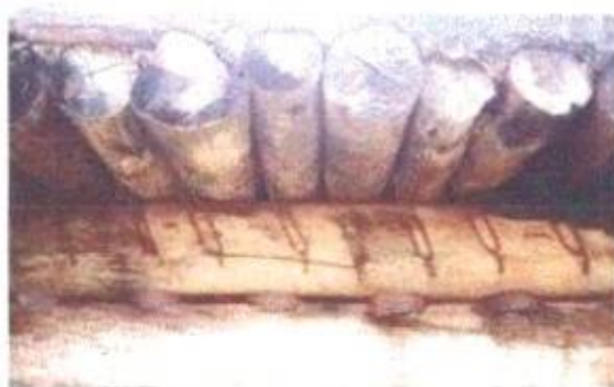
Figura 4 - Ponte em vigas com peças roliças compostas Fonte: Calil Junior (2006 p. 31).
