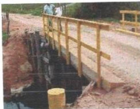
Figura 16 - Ponte com tabuleiro misto de madeira e concreto
